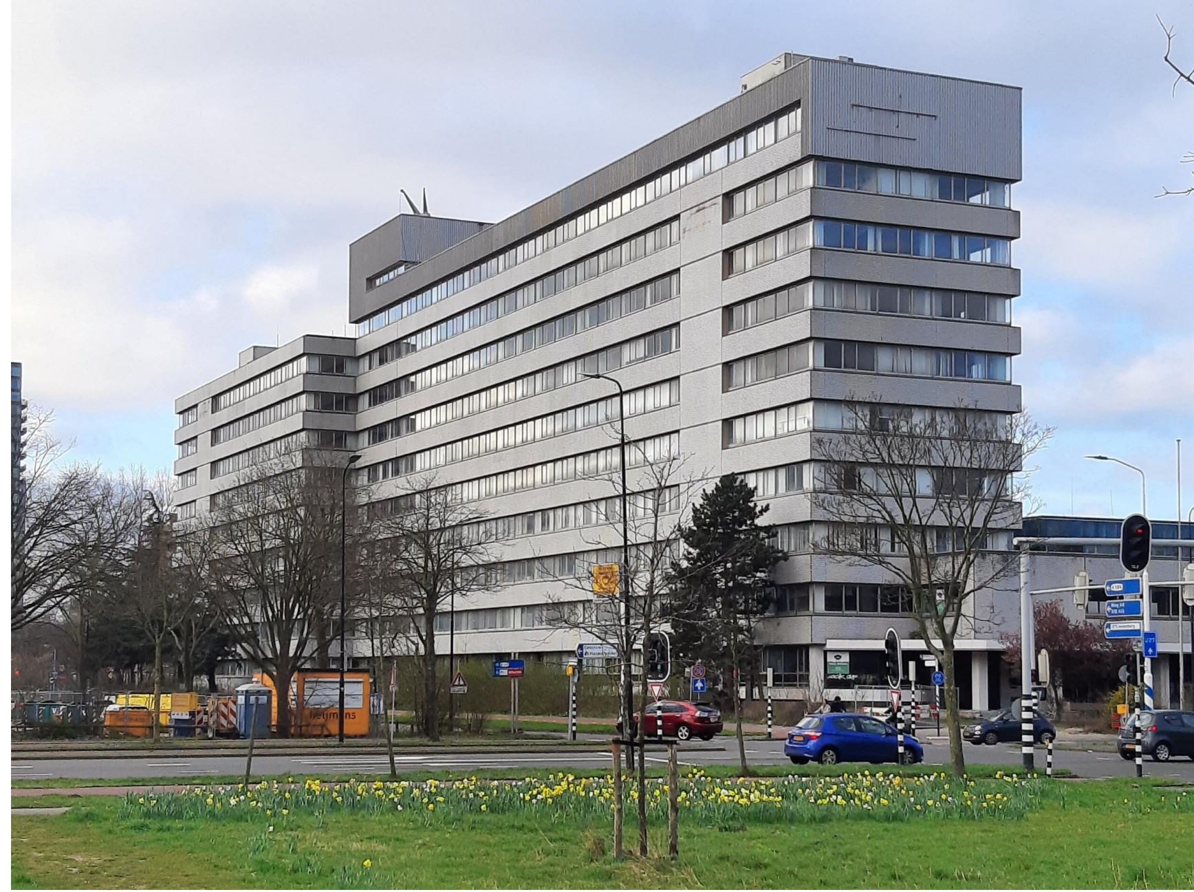
Foto HBG-kantoor (aanzicht Noord)
